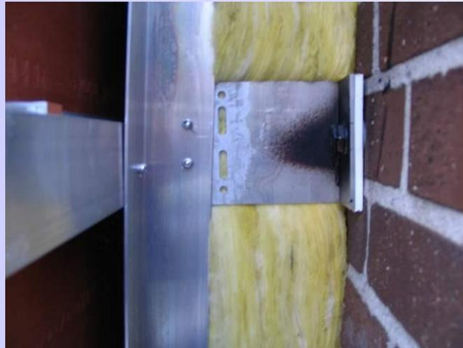
Unterkonstruktion mit Konsolen und Tragprofilen
